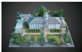
建物外観 (点群)
