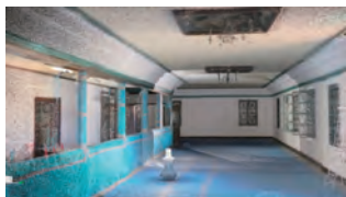
建物内部 (点群)
